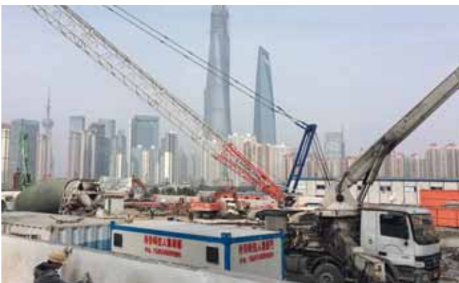
Gigantische neue Industriestandorte werden gebaut
